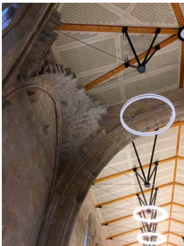
▲ Fig. 10. – La voûte du chœur et la charpente en carbone. © Architecture Patrimoine.
